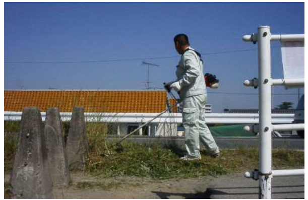
道路付近の草刈り状況
