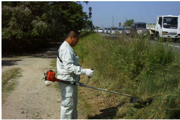
法面の草刈り状況
