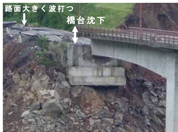
写真-5 阿蘇長陽大橋の右岸側橋台部
