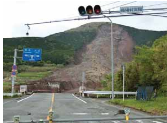
写真-1 阿蘇大橋西側斜面の大規模崩壊
