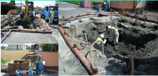
掘削時、ウエルポイント工法
