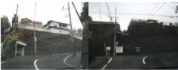
太白区緑ヶ丘1丁目／石積擁壁に変状なし(車中より)
