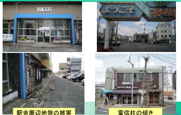
駅舎周辺地盤の被害
